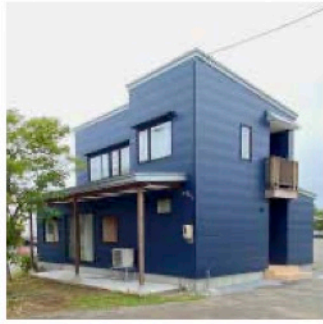
手前の外部物入れの屋根を玄関へ延ばし、雨よけにした構造。落ち着いた外壁にエントランスの木目が映える。
